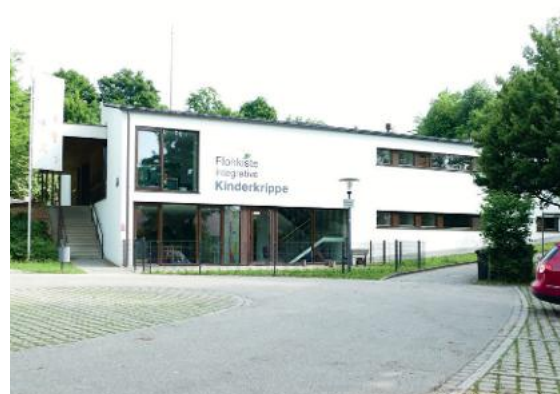
Abb. 45: Kinderkrippe der Gemeinde (Schulstraße)
