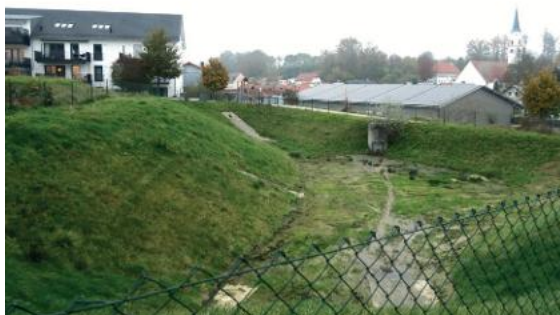
Abb. 68: Regenrückhaltebecken im Neubaugebiet Dobelfeld
