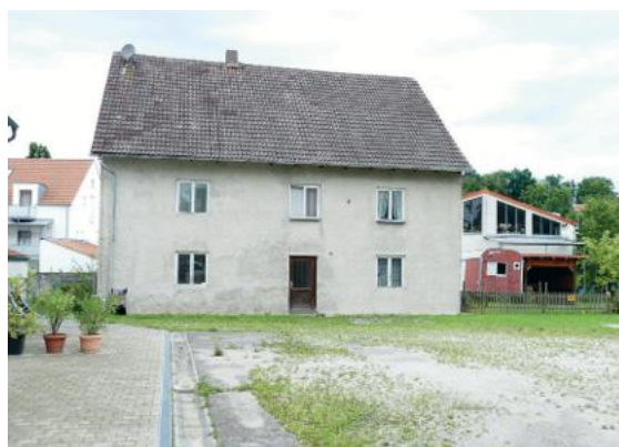
Abb. 21: Leerstehende Gebäude an der Kreuzung der St 2054 und St 2330 (oben) sowie in zweiter Reihe im nördlichen Teil der Hauptstraße
