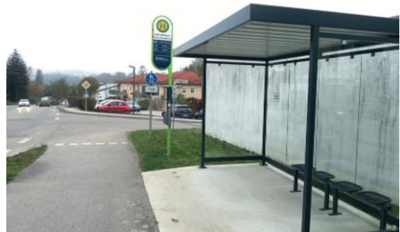
Abb. 35: Bushaltestelle Seniorenheim und Ende des Geh- und Radwegs am südlichen Ortseingang
