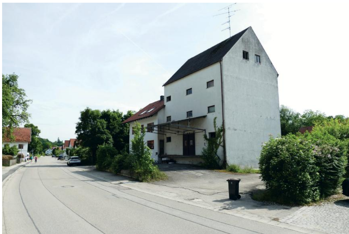
Abb. 19: Ehemaliges Lagerhaus in der Hauptstraße
