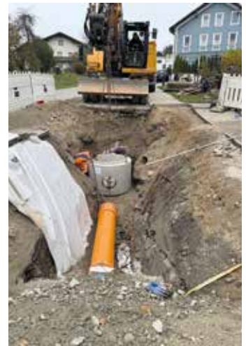
Neuhauser Straße - Kanalsanierung
