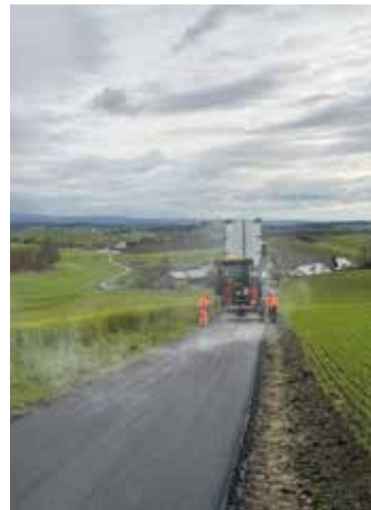
Asphaltierungsarbeiten Berginger Straße, Sulzbach Feiln-Schmidham und Rothhof Ruhstorf
