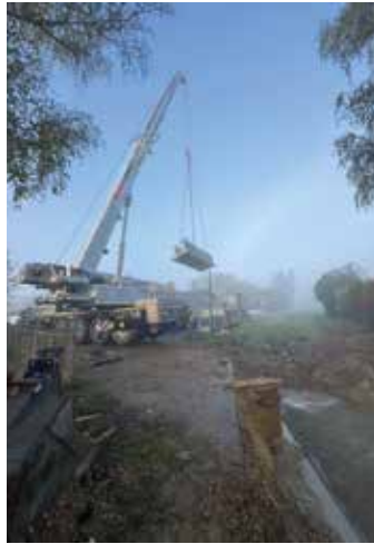
Ausbau bzw. Ertüchtigung eines Durchlasses in Hütting zur Verbesserung der Situation bei Starkregenereignissen
