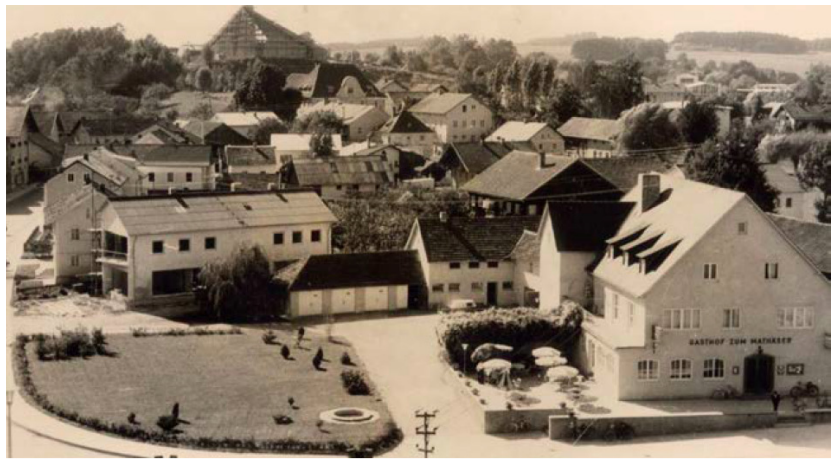
Bestandsfoto vor Umbau zu Hotel
