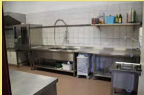
Die Übergangsküche in der Schmutterhalle. Foto: Leonie Schröttle
