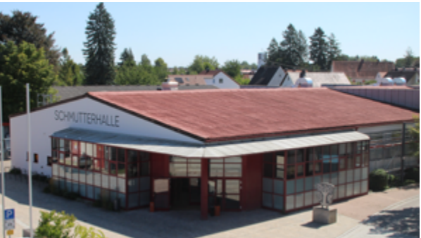
Die Schmutterhalle wird derzeit aufgerüstet. Foto: Leonie Schröttle
