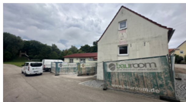
Das Schützenheim Diana Hamlar während der Sanierungsarbeiten. Foto: Firma Bauroom GmbH & Co. KG
