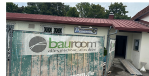
Das Schützenheim Diana Hamlar während der Sanierung. Foto: Firma Bauroom GmbH & Co. KG
