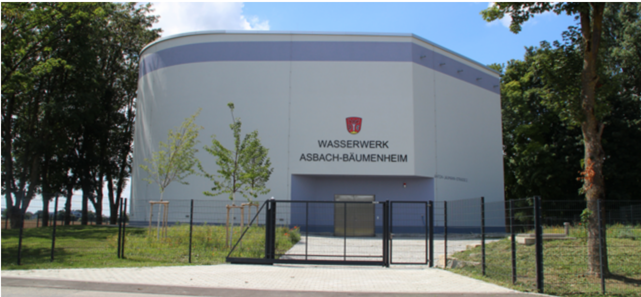
Die Außenanlage am Wasserhaus in Asbach-Bäumenheim wurde fertiggestellt. Foto: Leonie Schröttle
