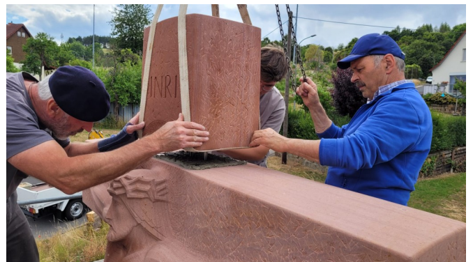
Die Aufstellung des rund drei Tonnen schweren Kreuzes verlangte neben technischem Gerät auch Nervenstärke und Fingerspitzengefühl.
