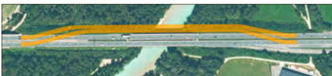
Nördliche Brücke wird als Behelfsumfahrung genutzt
