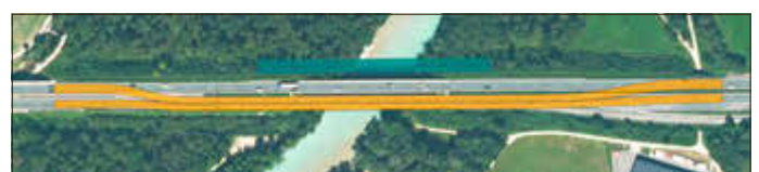
Verkehrsumlegung der südlichen Brücke
