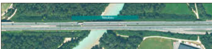
Bau der nördlichen Brücke
