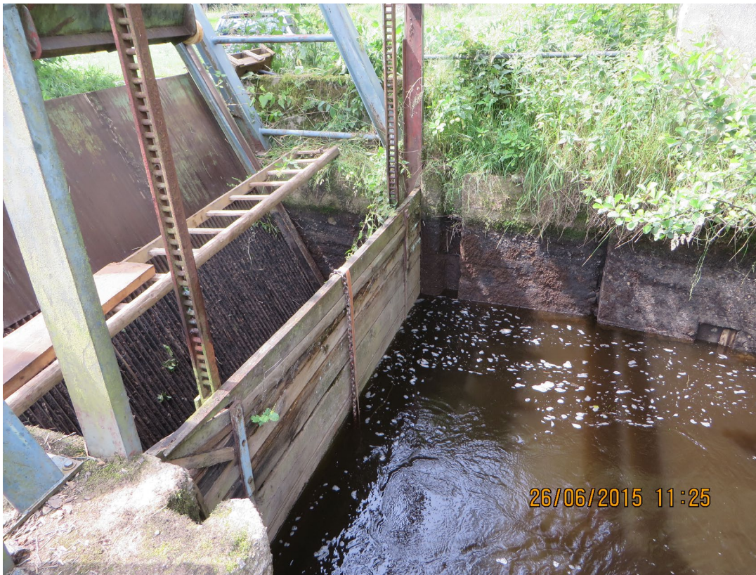
Bild: Einlaufbereich WKA Plärnmühle an der Fichtelnaab, Erbdorf
