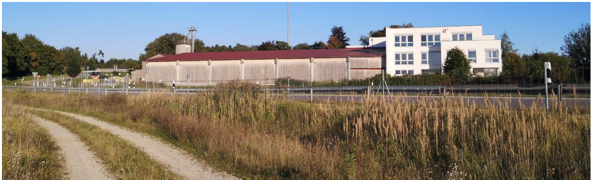
Abbildung 12: Blick auf das Gebäude der autobahnplus A8 GmbH (G1)
