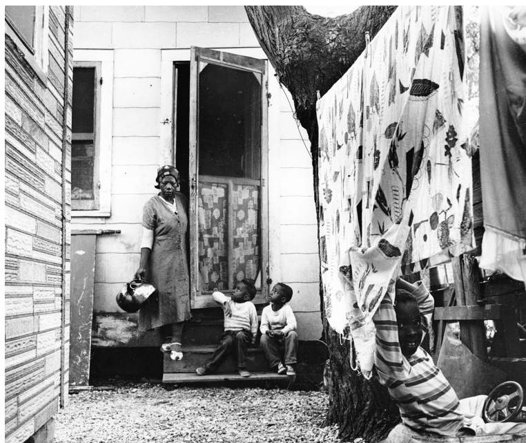
So sahen die Häuser in der Jane Alley aus, in der Louis Armstrong geboren wurde. Dieses Foto stammt aus den 1950er Jahren; 1956 wurde der gesamte Block abgerissen. (Fotoarchiv, Jazzinstitut Darmstadt)
