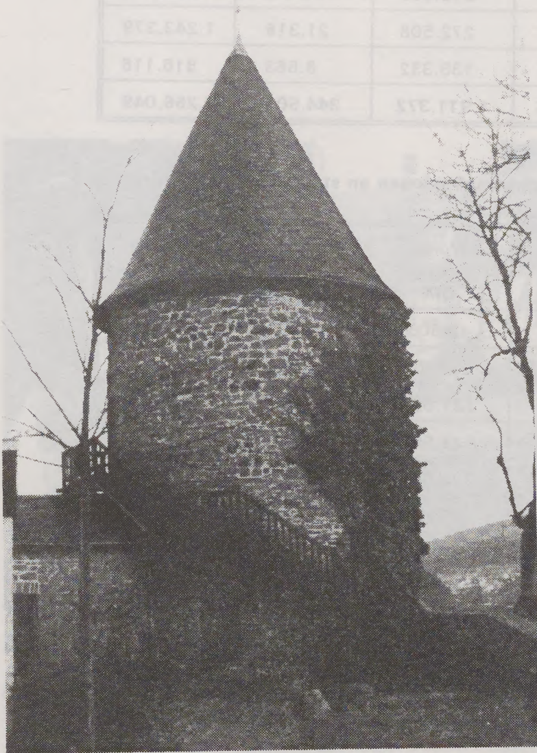
Hexenturm mit neuem Treppenaufgang
