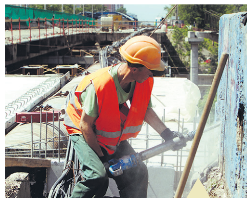
Триває ремонт Борщагівського шляхопроводу
