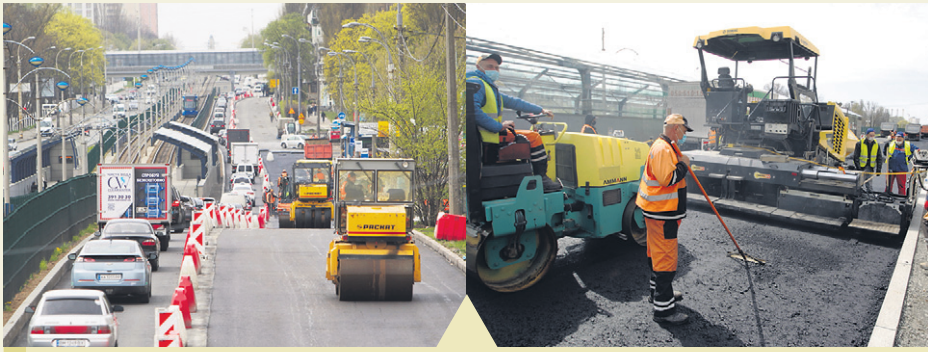
Одночасно з ремонтом Борщагівського шляхопроводу дорожники ремонтують велику ділянку проспекту Любомира Гузара вздовж лінії швидкісного трамвая.
