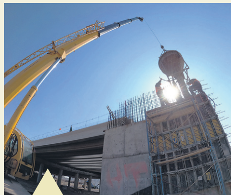
Йдуть роботи зі спорудження розв'язки на вулиці Богатирській на перетині з новою ділянкою Окружної дороги.
