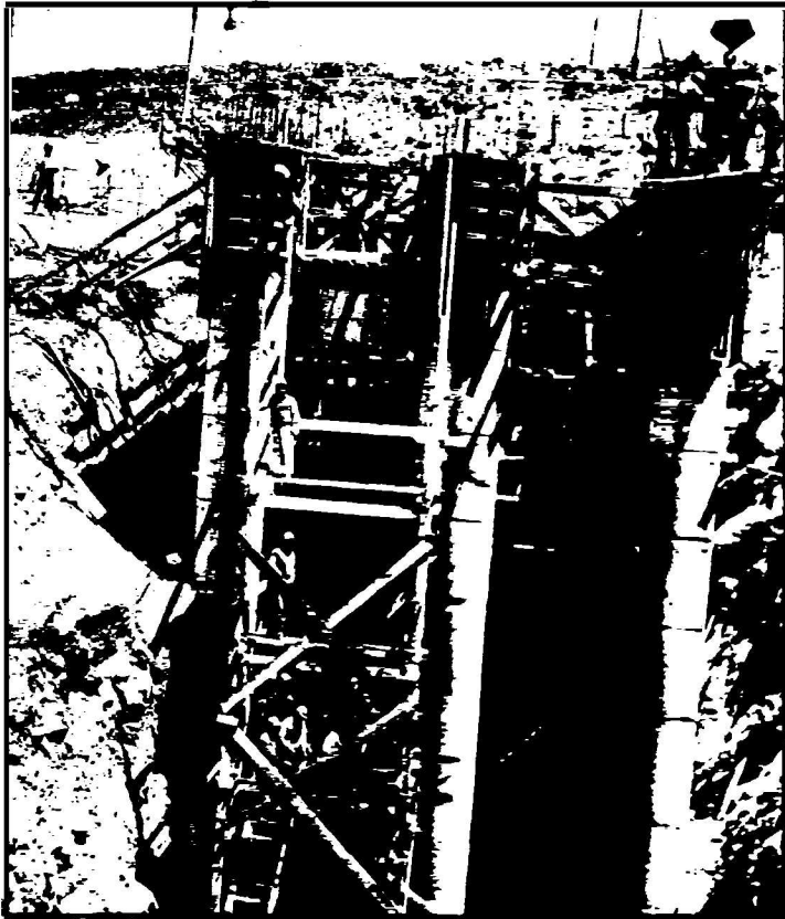
Entrada del túnel, cementado, de 235 metros de longitud, del complejo Hidroeléctrico Paso de las Piedras, obra de extraordinaria magnitud.
