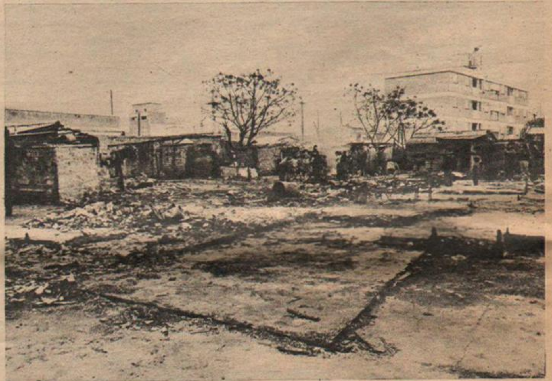
Con la colaboración de JP comienza la reconstrucción.
