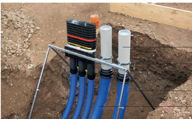
Höhenverstellbare Aufstellvorrichtung zur Fixierung der Fernwärmeleitungen.
